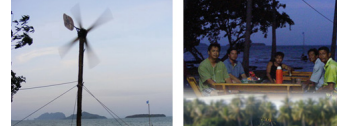
ช่างที่เกาะลันตาซึ่งไปให้ งานนี้คือช่างได้ทะเลไม่เอาสลิงค์เดี่ยวเป็นสนิมใช้เชือกดีกว่า(ในล่อน 12 มิล) 30 เมตร
